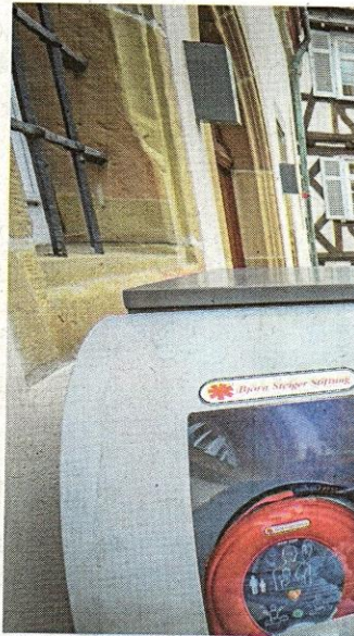
Oberbürgermeister Maximilian Friedrich klebt einen Hinweissticker auf den neuen Defibrillator, der am Briefkasten vor dem historischen Rathaus in Backnang installiert wurde. Im Hinter-
